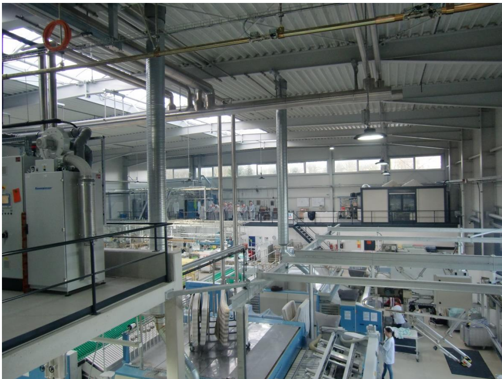
Ein Blick von der 1. Etage auf die Waschhalle
